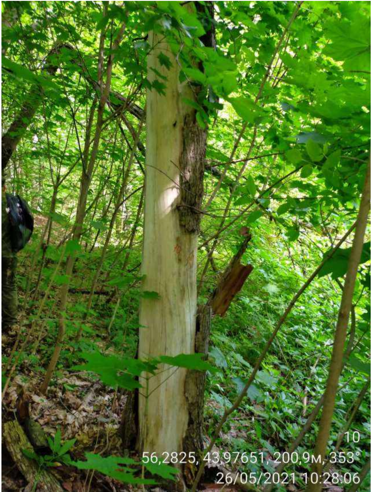
Дерево № 10 (Стволовая гниль)
